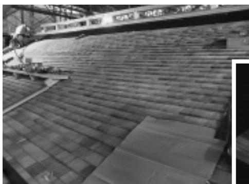
葺き上げの進む屋根
