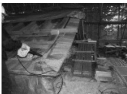
屋根の端部は雨仕舞いに十分耐えられるように幾重にも軒板を重ねます
