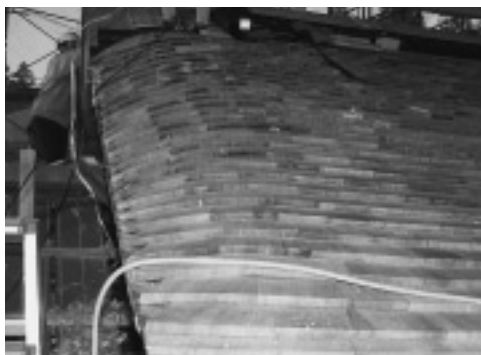
屋根全体の意匠を決める重要な工程の一つです
