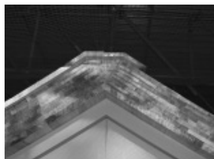
屋根の端部は雨仕舞いに十分耐えられるように幾重にも軒板を重ねます
