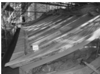
屋根葺きは軒づけ部から始めます
