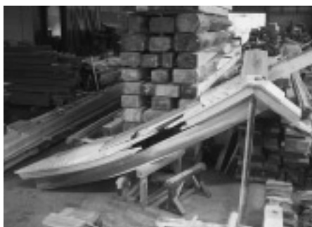
破風ぎわの原寸大模型を作り、実際に とし板を葺いて検討しました
