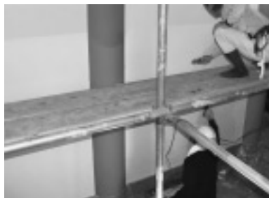
下付け・上付けと、水引きの加減を見ながら、一気に塗り上げます
