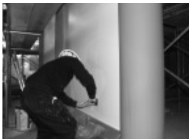
下付け・上付けと、水引きの加減を見ながら、一気に塗り上げます
