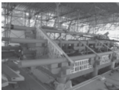
柱上に組物が組まれて桁材を受けます
