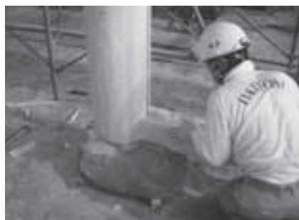
柱・地覆と礎石の調整
