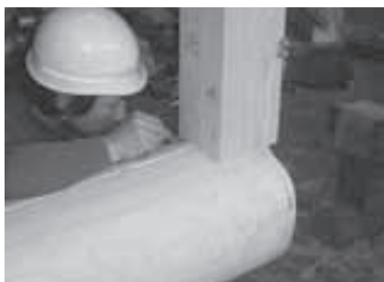
柱のひかりつけ
