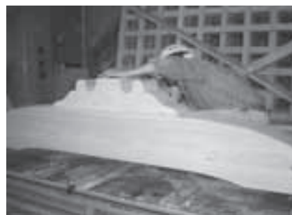
臺股と虹梁の取り付け具合の調整
