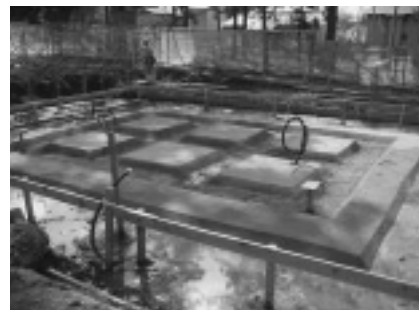
基礎地盤の造成
