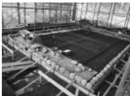
基壇外周に化粧石を設置
