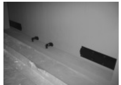
扉内側から見た八双金具と戸締り金物（中央）
