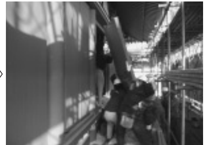
扉の軸を、上・下の順に軸穴に落とし込んで扉を設置します
