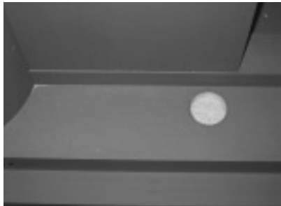
上下の長押しに、扉の軸を受ける6cm程の軸穴を開け軸受け金物を設置します
