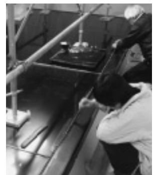
継ぎ目の布着せ作業
