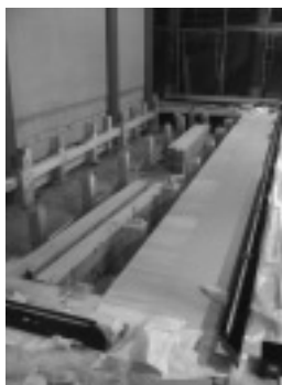
かまち 框部分の設置
