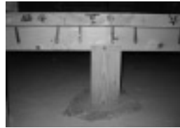
床板の めかす 目鋸釘
