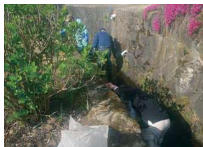
堰浚いの様子
