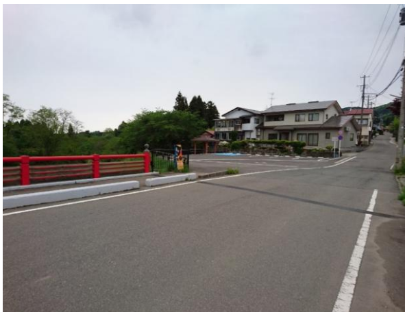
大型バス迂回場所(整備後)
