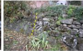
写真7 ㊸b石垣南側・北側石材形状差異（南西より）
