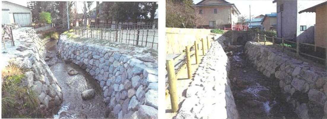
護岸改修(石積み)した花川
