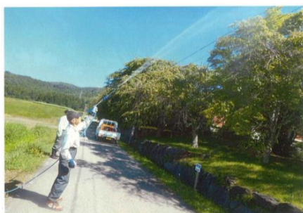
作業中の写真
