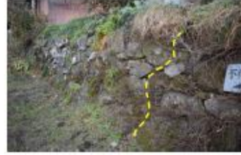
写真6 ㊸石垣南側・㊸a継目（南西より）
