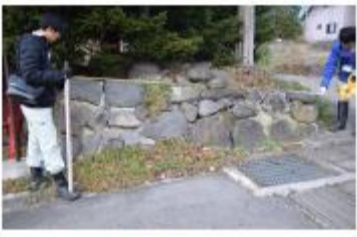
写真2 ①石垣 (南より)
