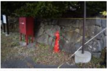
写真4 ②a 石垣南端・①との角部 (南西より)
