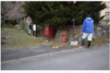
写真3 ②a・b・c 石垣全景 (南側町道より)
