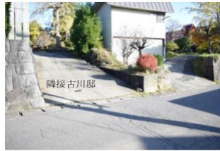
写真1 武田伸郎・古川邸入口部全景(北西より)
