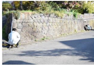
写真2 ①石垣全景(北西より)
