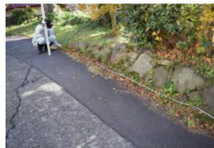
写真6 ②a石垣・②b石列継目部～②b全景
