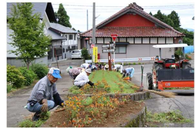
アプローチ整備事業(植栽) H30.6
