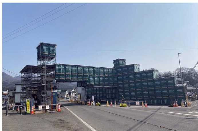
▲磐梯町横断歩道橋補修工事
