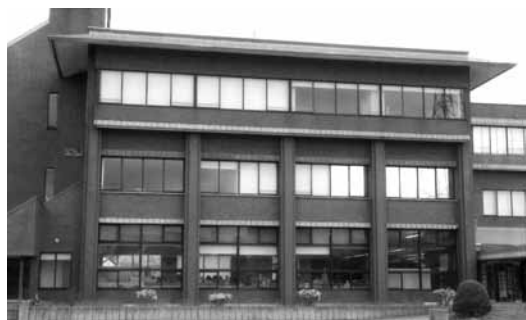
昭和56年建築の役場庁舎
