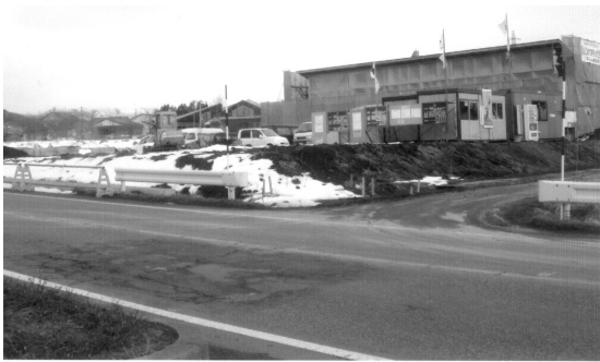
工事が進む活性化センター
