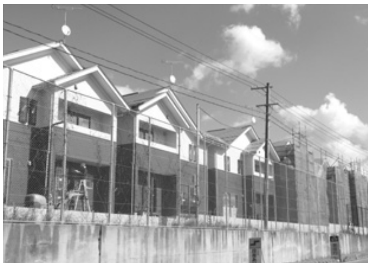
工事中の若者等定住住宅
