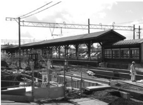
工事が進むまちづくり交付金事業 (駅前広場)
