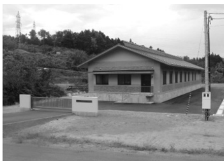
大谷地区農業集落排水処理施設
