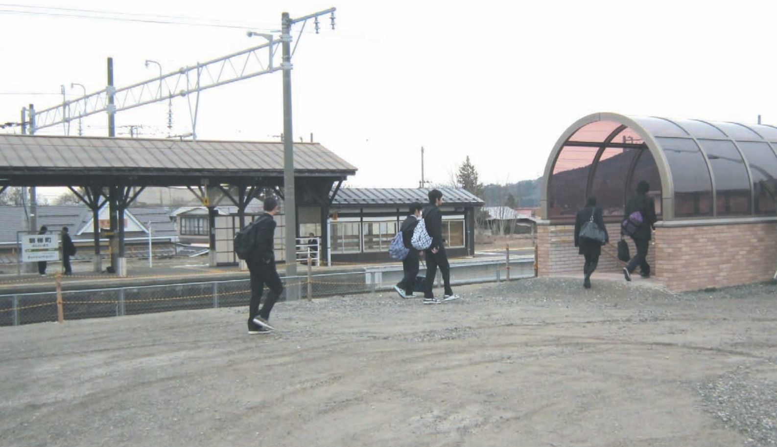
開通した磐梯町駅東口自由通路
