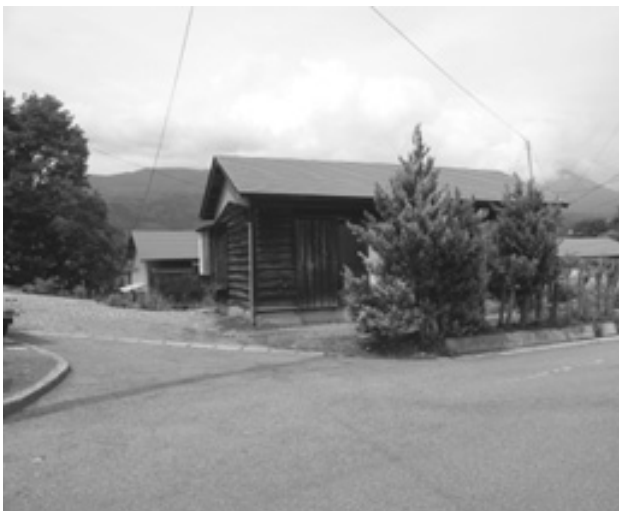
諏訪山町営住宅
