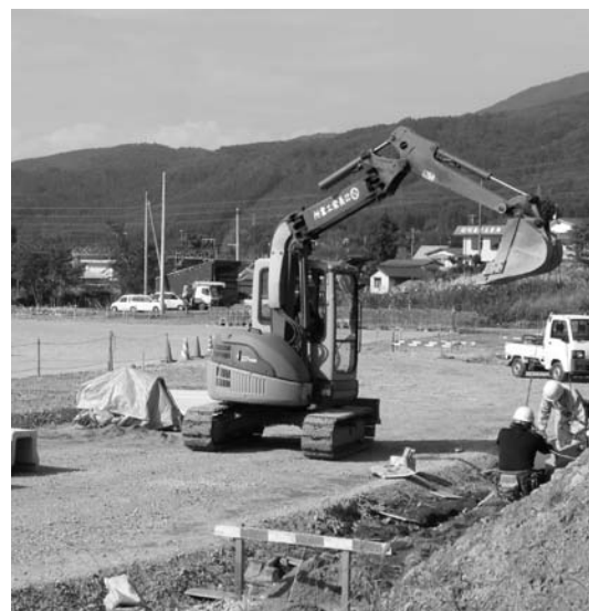
工事が進む駅前広場
