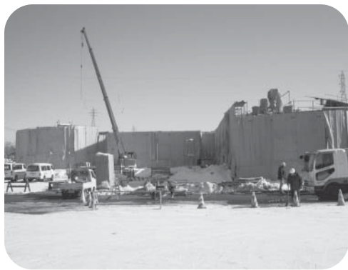
建設中の交流館
