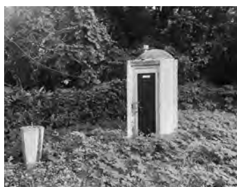
使用できない農村公園のトイレ
