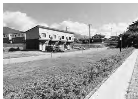
完成した賃貸住宅と宅地造成地
