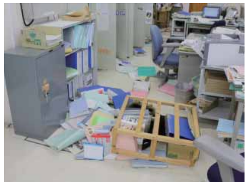
地震で棚が倒れて書類が散乱した役場庁舎内
