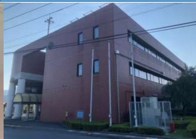
横瀬町役場（全景）
