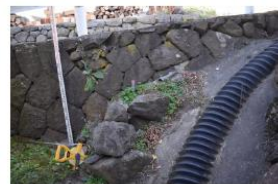
写真12 石垣東端部付近の状況
