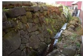
写真9 敷地東側の隣地鈴木邸石垣(北西より)
