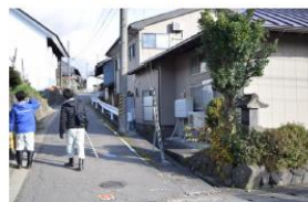
写真16 石垣と敷地北側の状況(西より)
