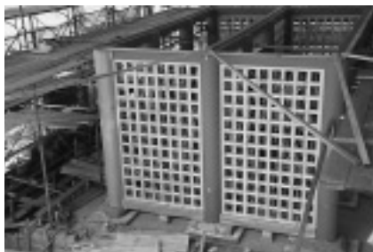
柱間に木格子を落とし込み下地とします
