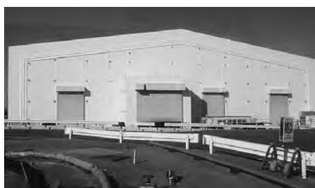
汚染水を処理するアルプスの建屋
