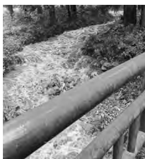
花川護岸工事未着手箇所
