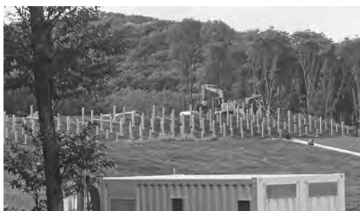
太陽光パネルを載せる架台の建設が進む法正尻地区
