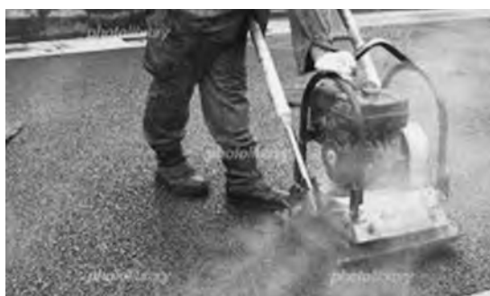
道路補修作業のイメージ
