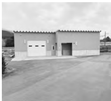
防災備蓄倉庫施設（町民グラウンド隣）
