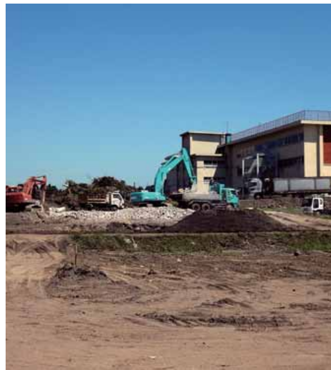
用地造成が進む現場
