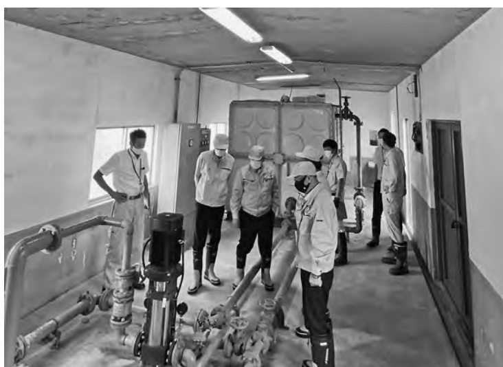
▼ 施設内の機械の確認
