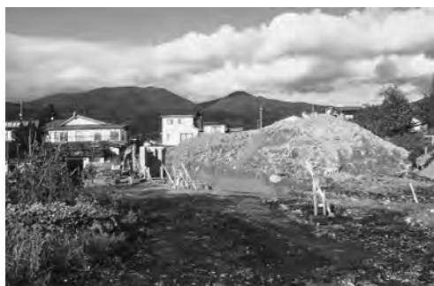
東松山地区の宅地造成工事
