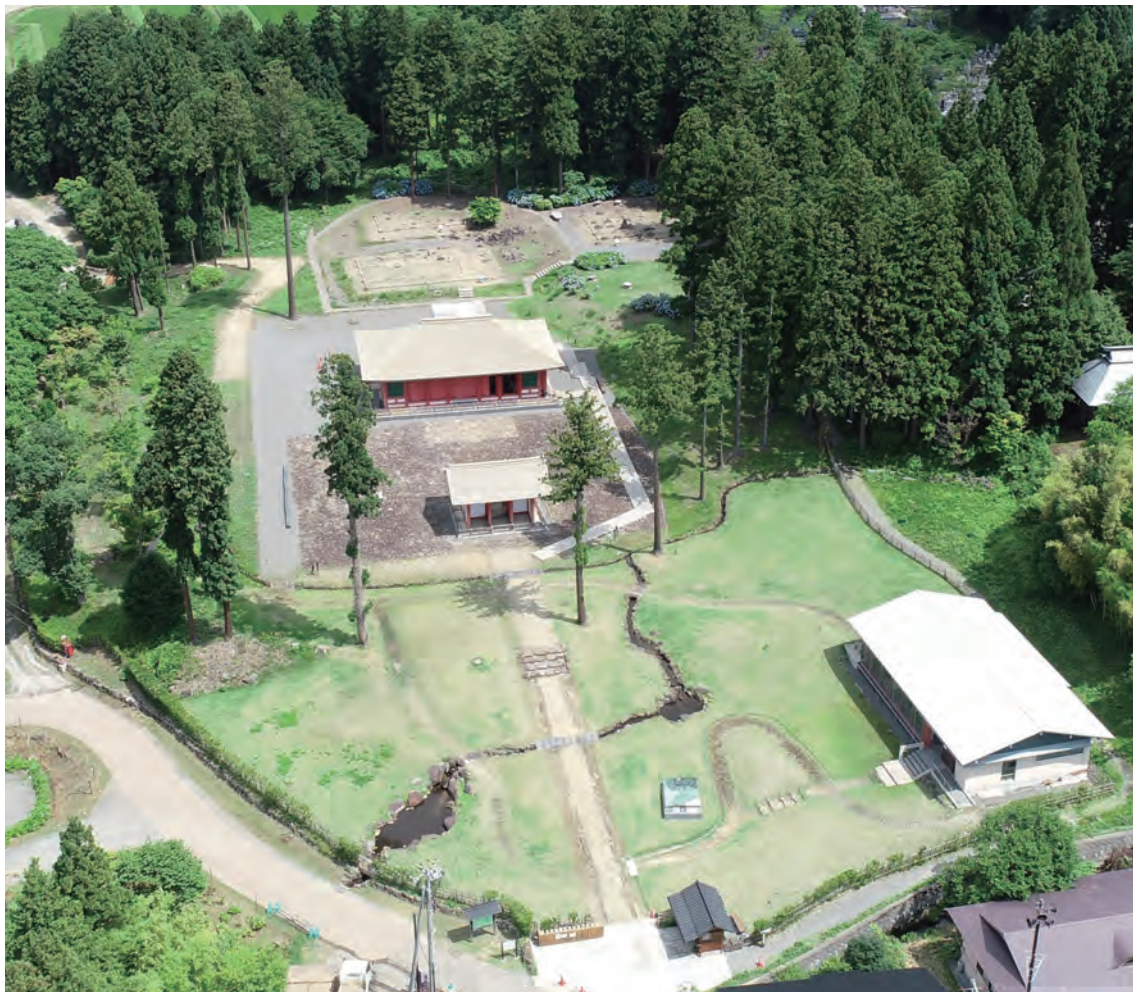
整備後の中心伽藍全景
