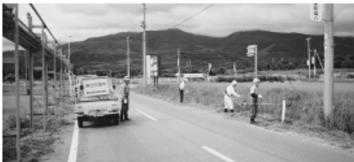
草刈作業風景(町道一の沢法正尻線)
