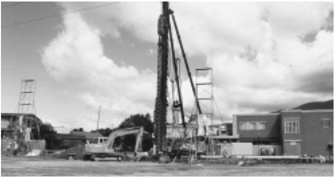
工事中の介護老人保健施設
