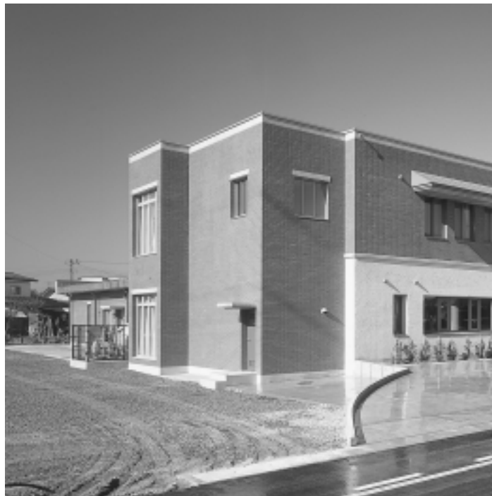
完成した医療センター
