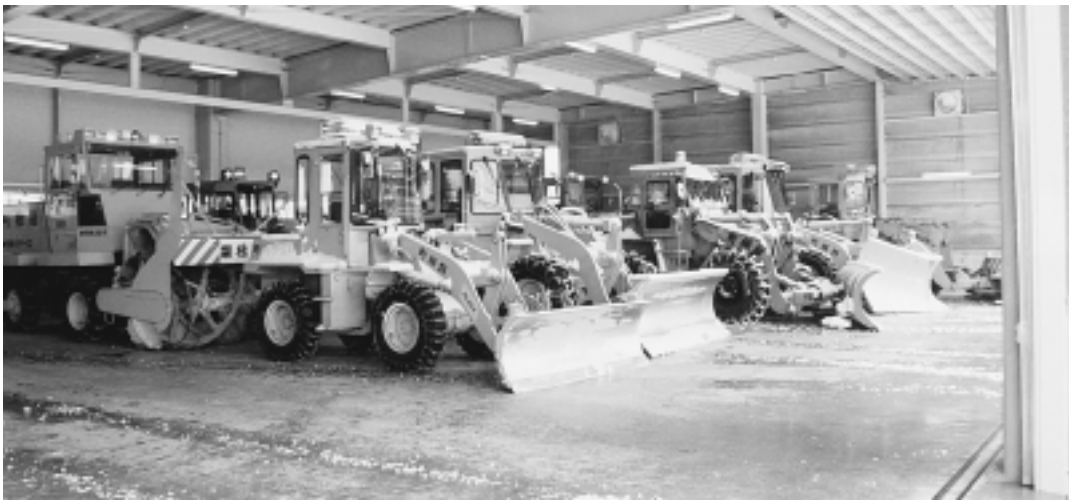
完成した除雪車庫
