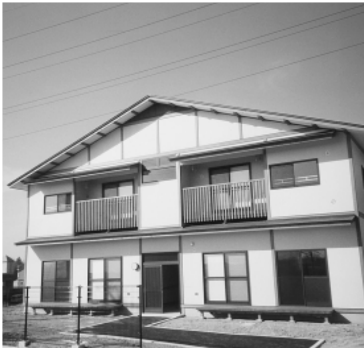
完成したこぶしヶ丘町営住宅
