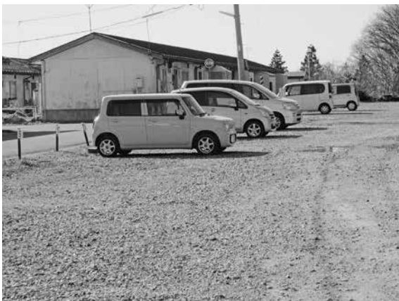
未舗装の諏訪山町営住宅駐車場
