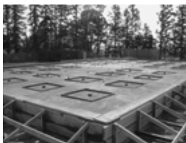
配筋後基礎コンクリートを打設
