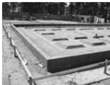
安山岩の切石を用いて基壇外装を設置
