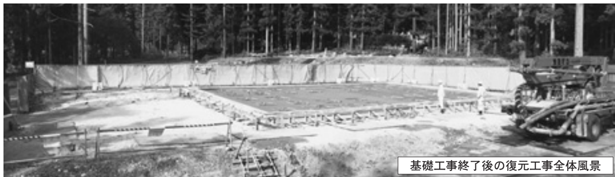
配筋後基礎コンクリートを打設
