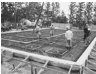
配筋後基礎コンクリートを打設
