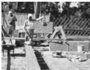
安山岩の切石を用いて基壇外装を設置
