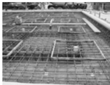
基壇内部に配筋
