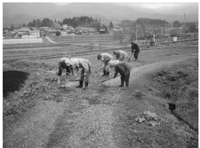
共同作業による道路補修
