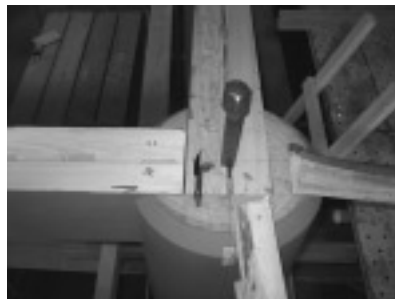
わなごみ 柱と頭貫の仕口は「輪難込、大釘打」
