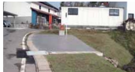
設置された防火水槽
