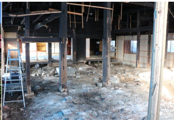
内部解体状況
