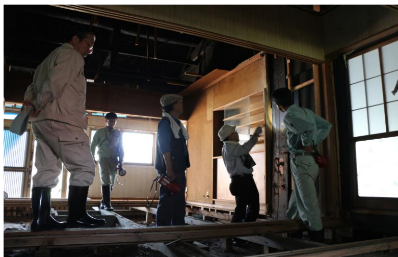
旧吉田家住宅解体調査
